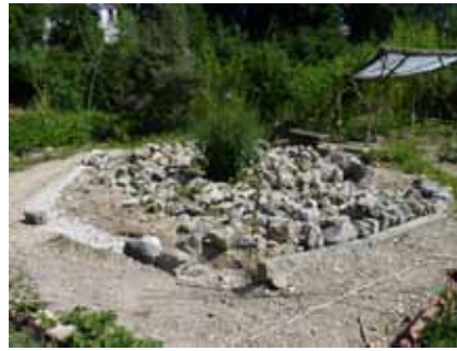
Workshop Trockenmauerbau am ÖBZ, Baumaterial: Grauwacke (unbehauen)
